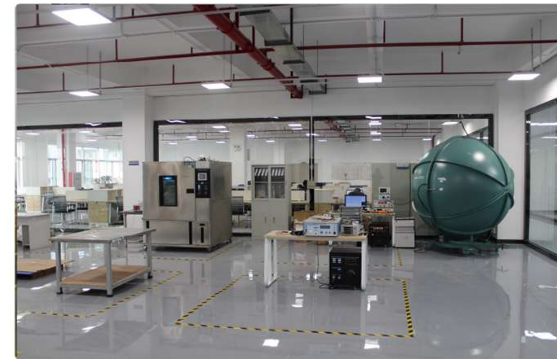
工程部試験区
